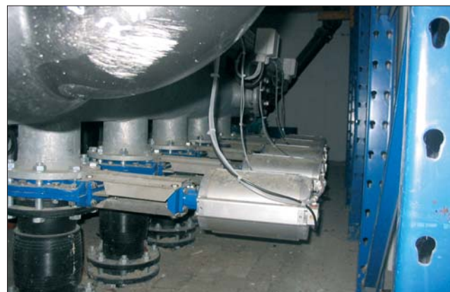
Ilustracja 4. Zasuwy ZETA® z napędami pneumatycznymi
