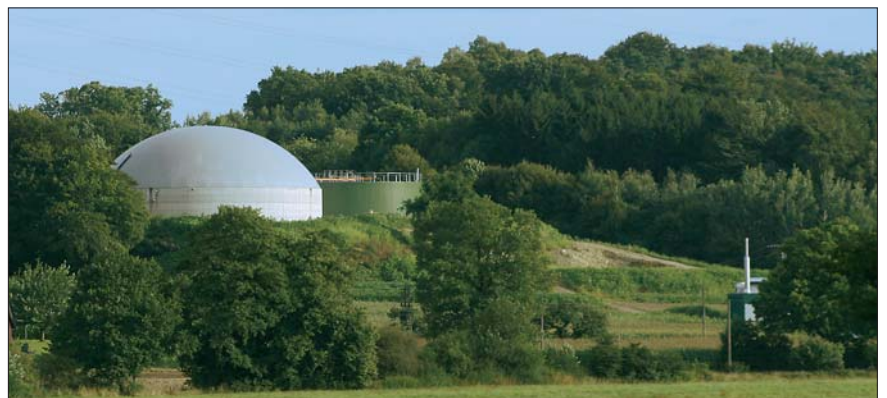
Ilustracja 2. Instalacja do wytwarzania biogazu w Tecklenburgu
